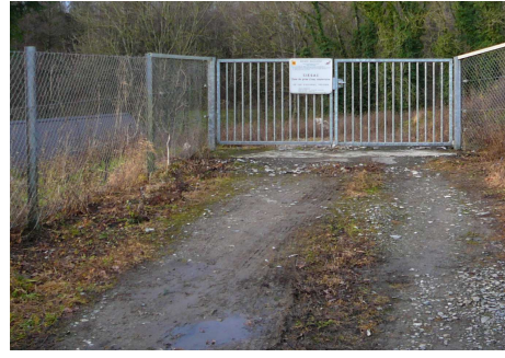
Le passage du bief sous le talus du RAVeL
